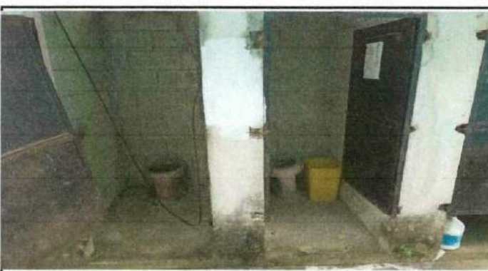
Foto 4: Cambio de tazas sanitarios.
