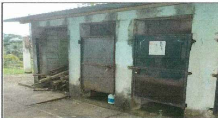
Foto 3: Cambio de 2 puertas de baños y 4 tazas sanitarios.
