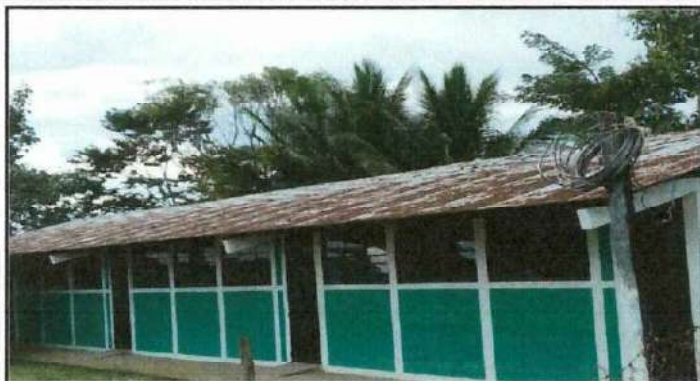
Foto1: Cambio de Techo de 3 aulas, dirección y 1 bodega.
