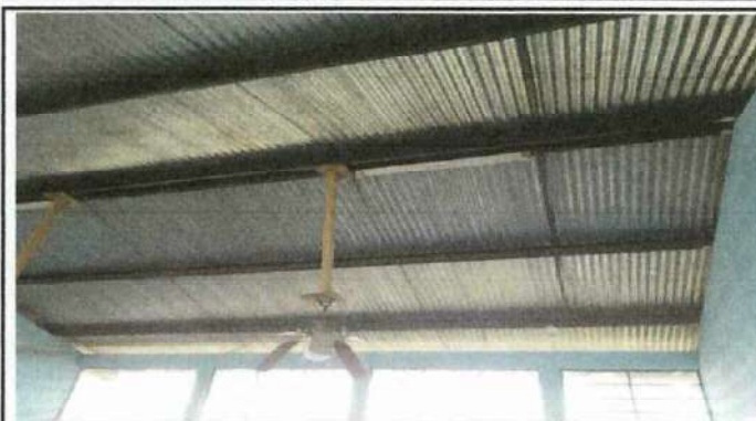
Foto 2: Parte del interior del edificio.
